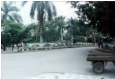
FOTO No. 9. Muestra: Puente sobre el Río Tuluá (Calle 27).
