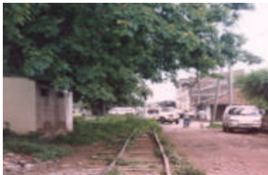
FOTO No. 16. Muestra: Vía Férrea sobre la calle 19 futura doble calzada.
