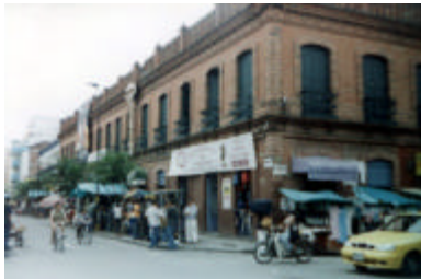
FOTO No. 21. Muestra: Teatro Sarmiento (Calle 27 Carrera 23 esquina)
