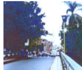
FOTO No. 3. Muestra: Puente sobre el Río Tuluá, Calle 26
