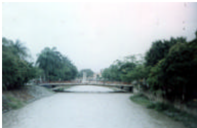
FOTO No. 18 Muestra: Puente sobre el Río Tuluá.
