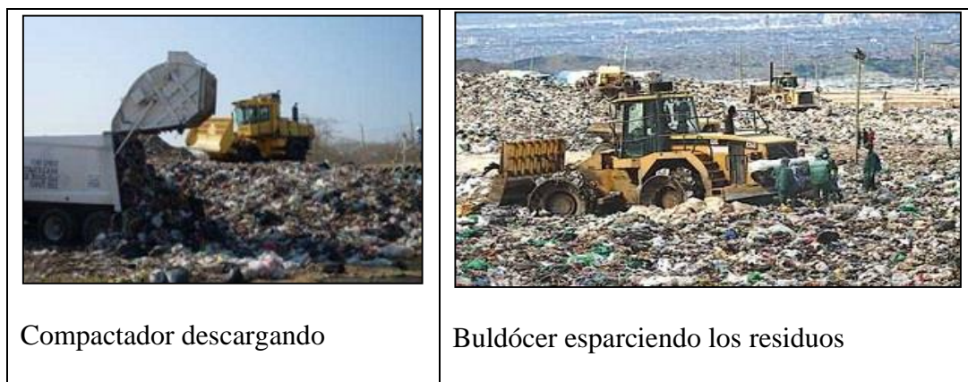
Figura 4-6: Operación del relleno sanitario.
