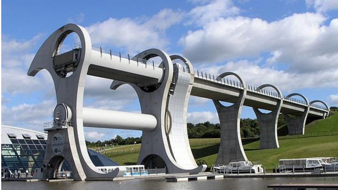
Figura A-12: Rueda de Falkirk en el Canal “Clyde – Forth” Glasgow - Edimburgo, Inglaterra [64]
