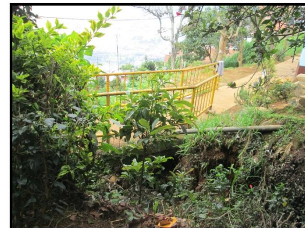
Puente sobre la quebrada Carevejia
