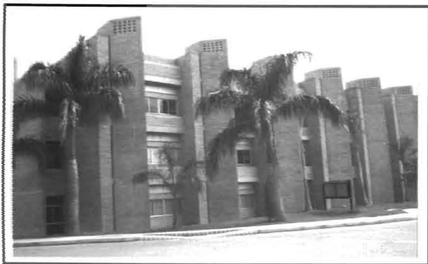
Edificio de Laboratorios de Investigación - Núcleo de El Volador
