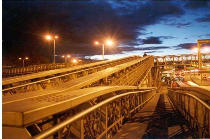
Figura 4-2. Rampa de puente peatonal del sistema
