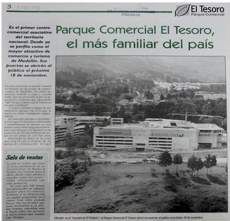
Figura 1.8. Construcción Parque comercial El Tesoro, Publicación institucional, 1999.
