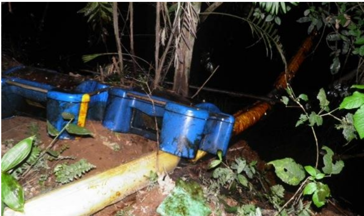
Fotografía 7. Tanques rebosados de crudo y oleoducto, afectaciones al ecosistema en Cunamá-Plan Brisas, Aguazul, Casanare (2012)
