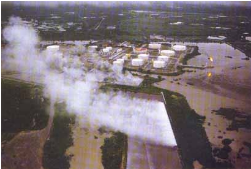
Planta de almacenamiento de crudos en Caño Limón, Arauca. Foto: Diego Garcés.
