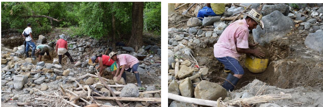
Figura 0-11. Actividades de excavación. Sabanalarga, Antioquia.
