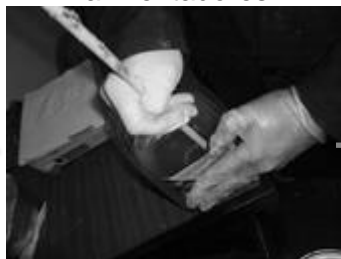
Preparar la resina y mezclarla con el endurecedor.
