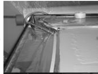
Colocar tubos alimentadores.
