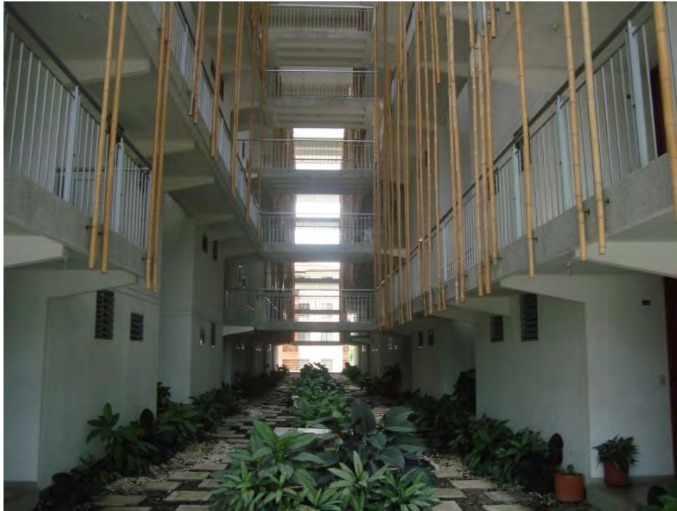
Ilustración 54: Fotografía Patio Interior Bloque D sayab/2013
