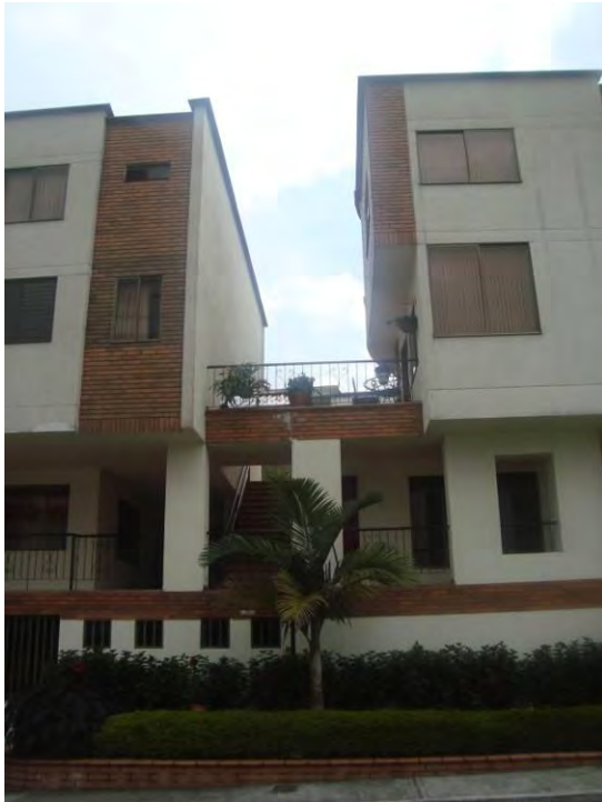
Ilustración 57: Fotografía Fachadas Exteriores Bartolomé de las Casas/2013
