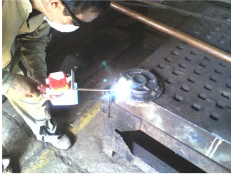
Figura 2.4 Proyección térmica en proceso.
