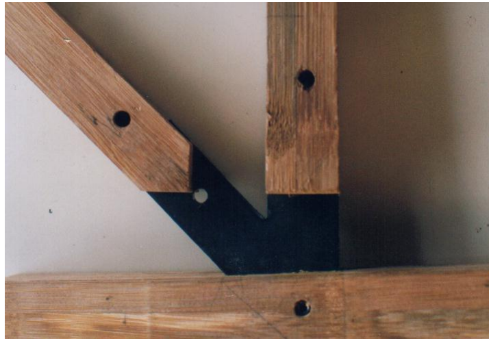
Figura 64 Propuesta de unión con platina interna
