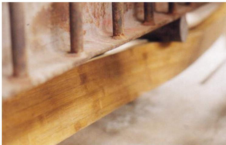
Figura 33 Falla por pandeo lateral de vigas de guadua laminada pegada Moreno José Ignacio
