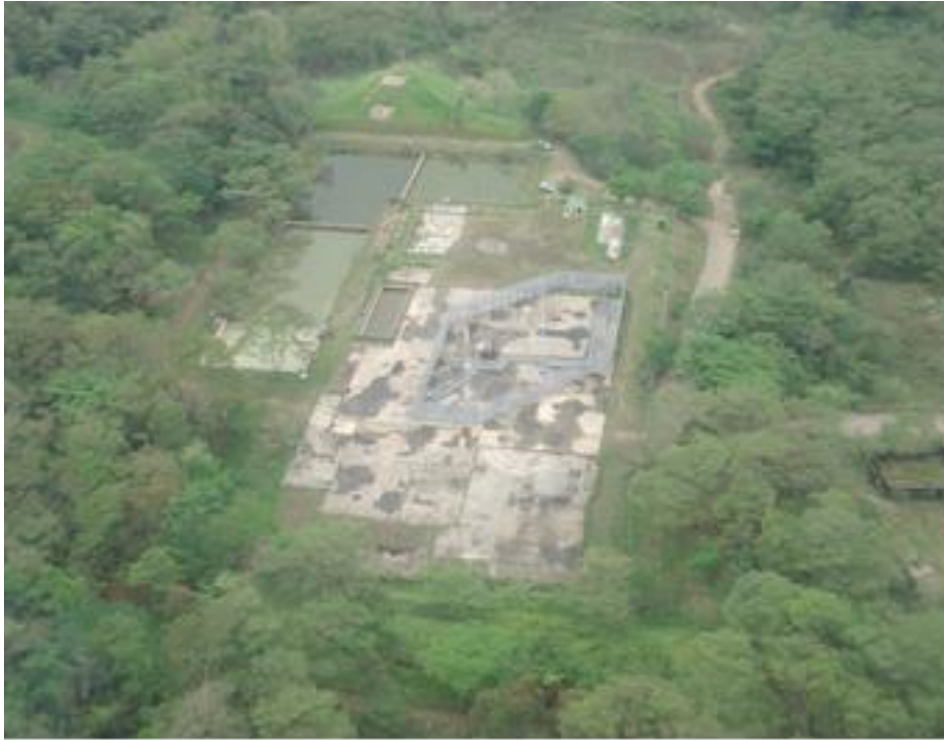
Imagen 3: fotografía aérea del área de pozos Floreña A.
