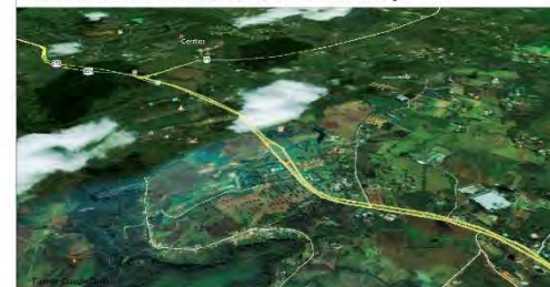
Vista Aerea Corredor suburbano Via Pereira - Cerritos - Cartago
