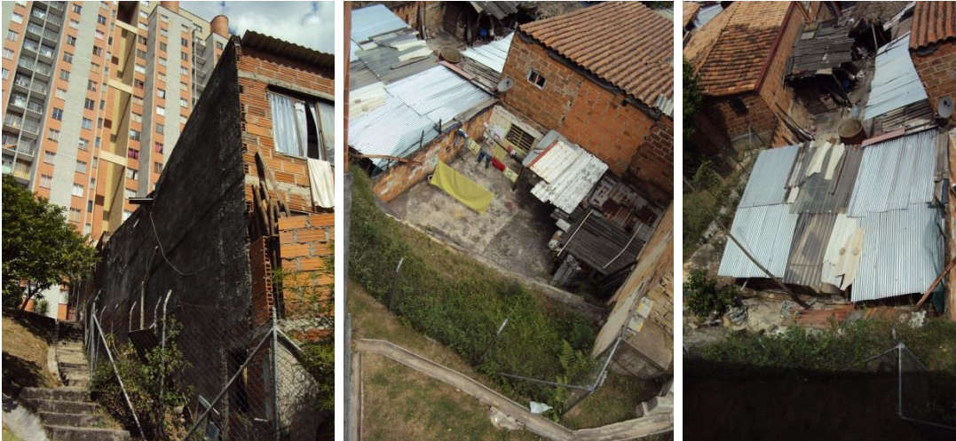
Figura 53. Casa contiguas al proyecto. Estas casas están inmediatamente después del cerramiento del proyecto. Debido a la proximidad y a la altura del proyecto, hay registro desde los edificios hacia las casas.
