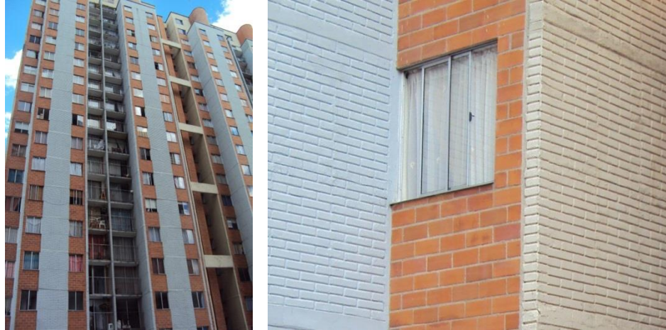
Figura 63. Materialidad. Muros en concreto y ladrillos de arcilla
