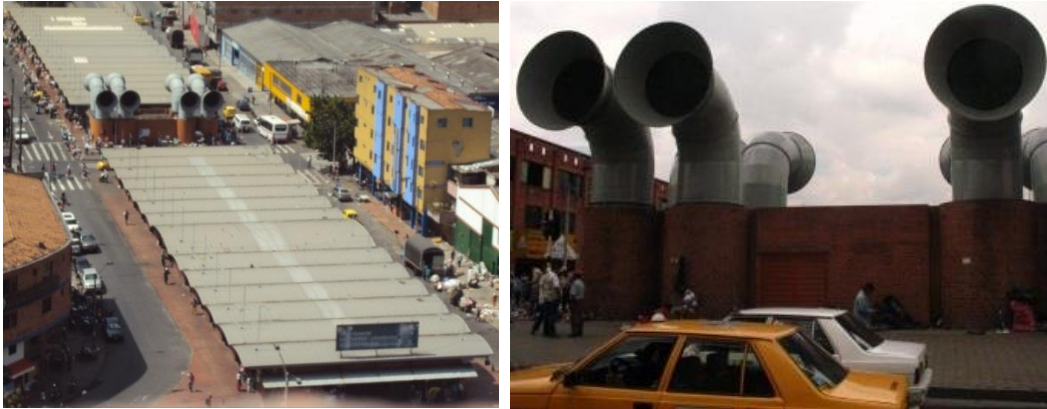
Figura 72. Bazar de los Puentes visto desde Prado de Villanueva y extractores de gases de monóxido de carbono en el Bazar de los Puentes 226 .
