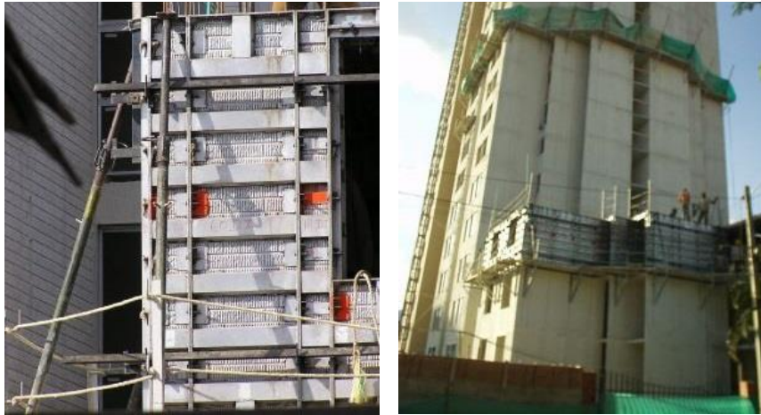
Figura 79. Muros vaciados en concreto 239
