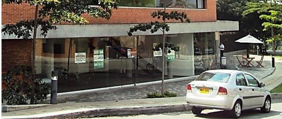
Figura 95. Locales comerciales hacia el exterior.
