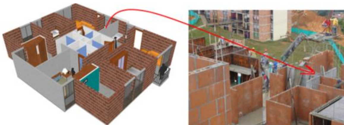
Figura 43. Muros vaciados en concreto.
