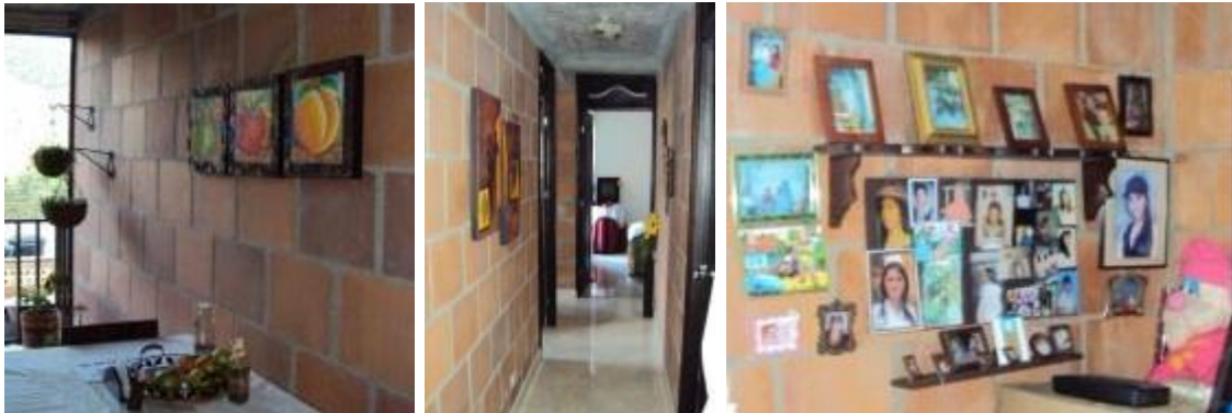
Figura 42. Mampostería en arcilla
