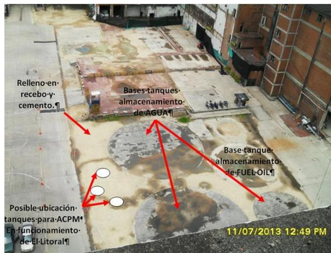
Foto 2: Ubicación de las bases de almacenamiento de agua y FUEL OIL (El Litoral - Bavaria), junto con la posible ubicación de los tanques de almacenamiento de ACPM, (El Litoral).
