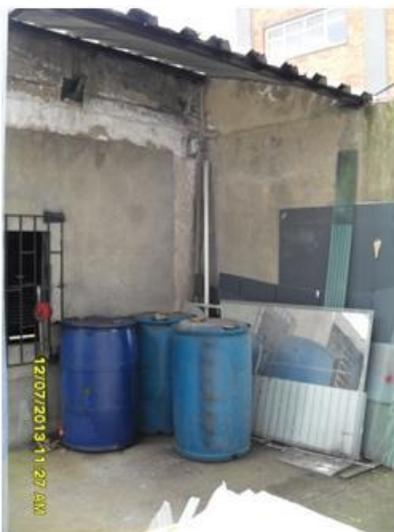
Foto 1. Área de almacenamiento de ACPM. Cuenta con techo, no posee dique de contención de derrames
