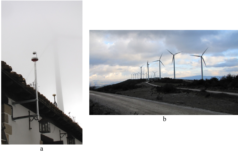
FIGURA 4.19: Características del lugar de instalación de los sensores. a. Montaje del molino de campo en la estación no. 10. b. Característica de montaña de la estación no. 2.
