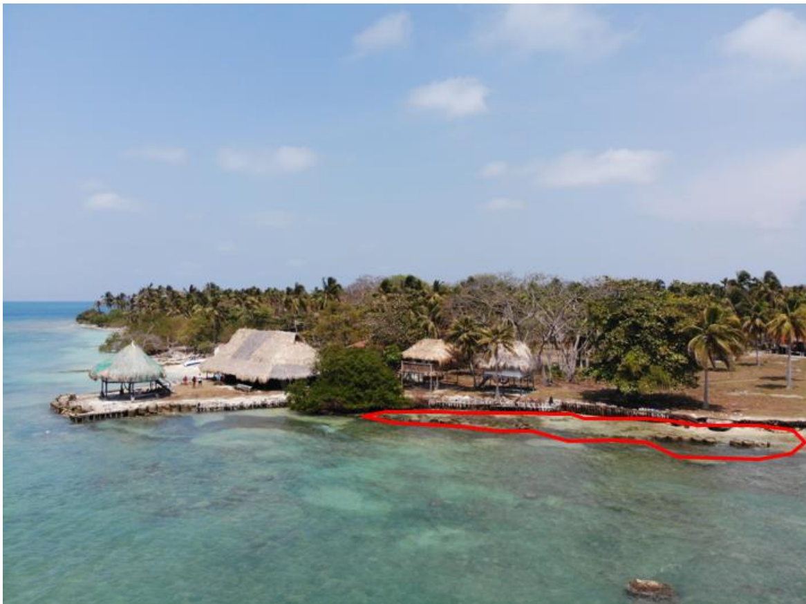
Figura 4-7: Primeras obras rompeolas Dahlandia
