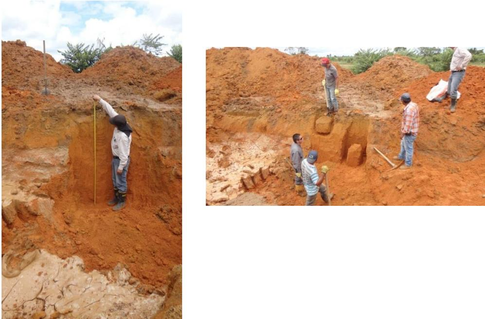
Fotografía 3-2. Detalle de la excavación de la cual se extrajeron los bloques de suelo. Localización N 04°30'07.8, W 70°36'33.3" (Ceiba-Dromos, 2014)
