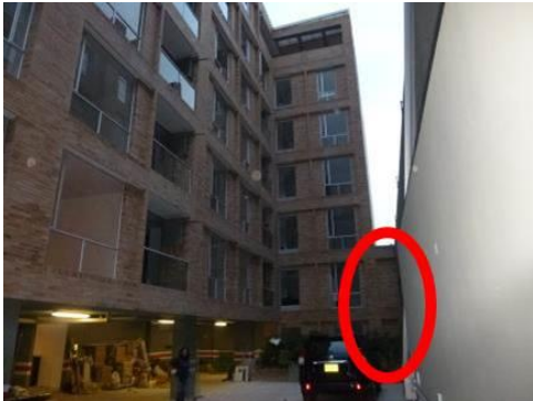
Figura 10-2: Desplazamiento paramentación por diferencias en dimensiones del lote.
