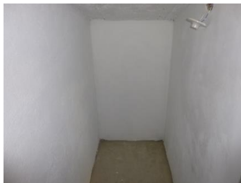
Figura 10-9: Altura reducida depósito por estar debajo de rampa vehicular
