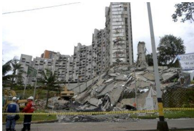
Figura 1-1: Colapso Torre 6 Edificio Space en Medellín
