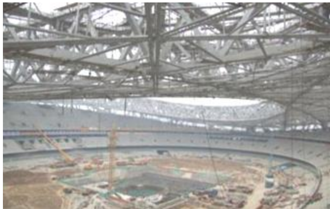
Figura 5-8: Construcción cubierta Nido de Pájaros
