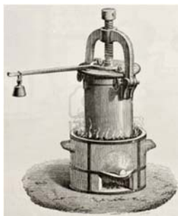
Figura 10. Digestor de Papin o Marmita de Papin. Sirve para someter un sistema a una presión elevada.
