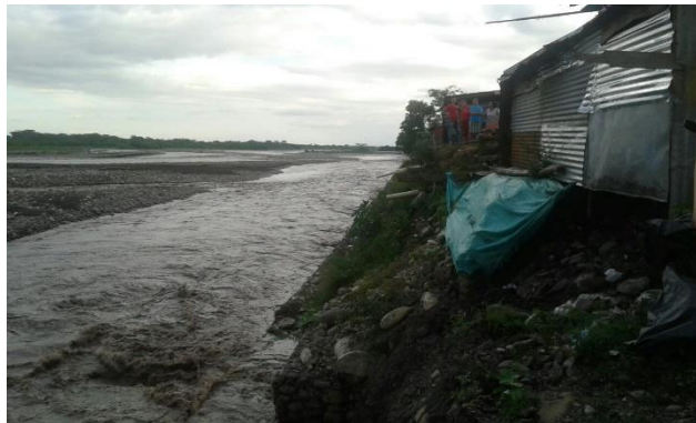
Imagen 10. Socavación del río Guatiquia. Asentamiento Brisas del Guatiquia. Villavicencio, Colombia. Fuente: Elaboración propia. 2018
