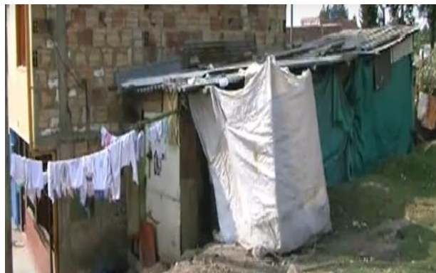
Imagen 50. Autoproducción de viviendas, sobre el jarillón del Río Bogotá. Porvenir Rio. Fuente: Corporación Autónoma Regional CAR. 2010
