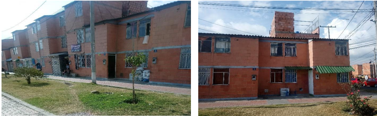
Imagen 21. imagen 22. A la izquierda, viviendas modificadas a partir de las necesidades, también se observan pequeños negocios. A la derecha, viviendas originales, de fondo, se está ampliando una unidad. Fuente: Elaboración propia. 2020.
