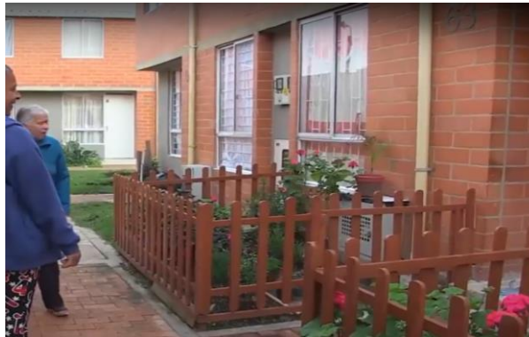
Imagen 67. Mejoramiento de espacios comunes. Fuente: Esta investigación. 2019
