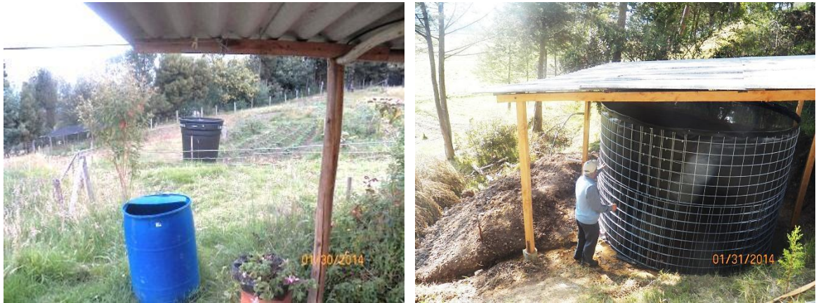
Figura 18: Caneca de 100 L y tanque 1.000 L para la recolección improvisada de agua lluvia, Finca Mis Sueños, Paipa (izq.); tanque de 20.000 L para almacenamiento de agua lluvia captada por la superficie de un invernadero, Finca El Morro, Guasca (der.).
