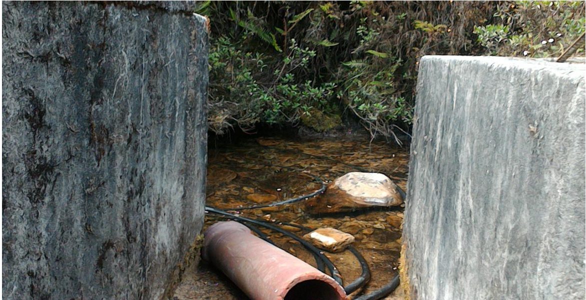
Ilustración 7: Bocatoma del Acueducto Cerrito Blanco
