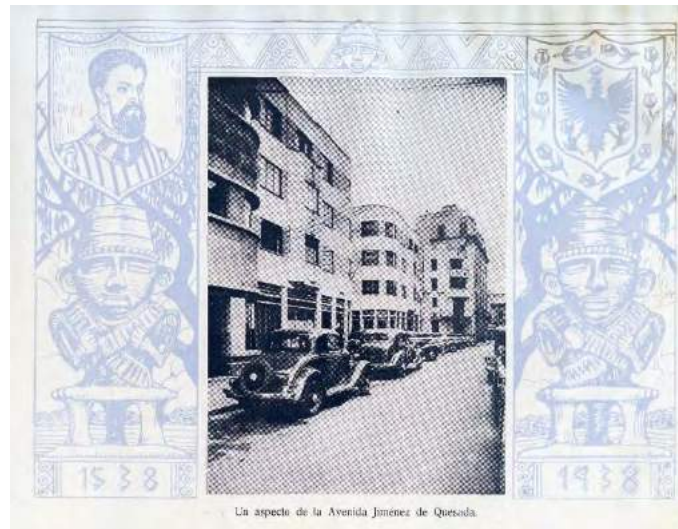
Imagen 58.2. Pasaje Santafé y edificio del Diario El Tiempo, en la avenida Jiménez
