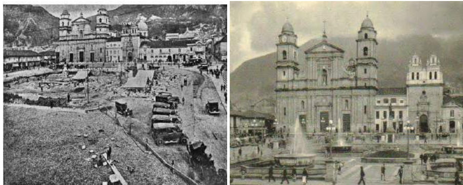
Imagen 5.6. Obras y transformaciones en la Plaza Mayor de Bogotá.
