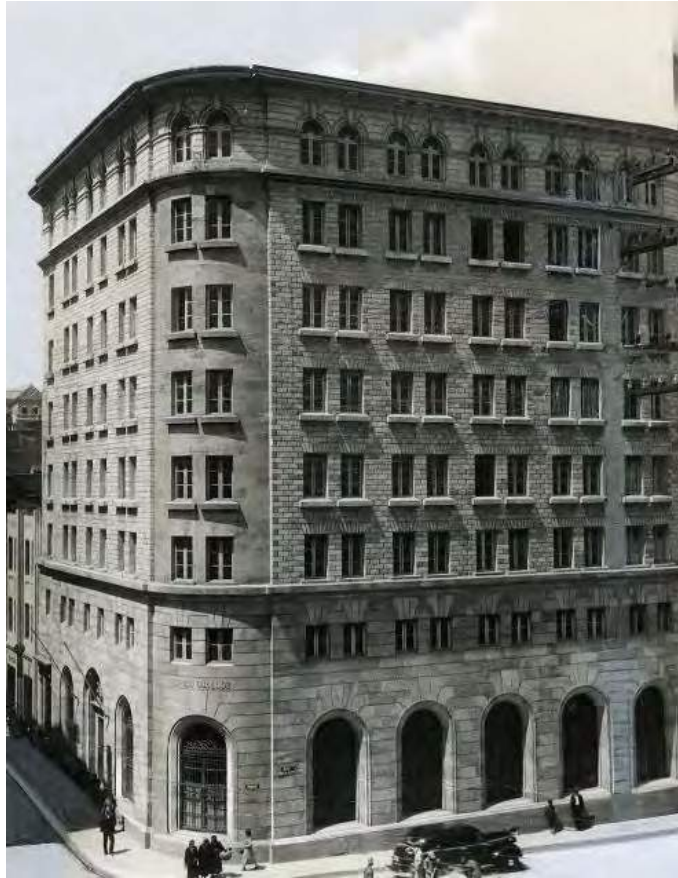
Imagen 57.2 Edificio Cubillos, primer rascacielos de Bogotá
