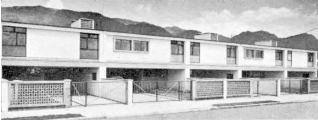
Imagen 34.5. Conjunto Casas Ponce. Exterior. Barrio El Retiro
