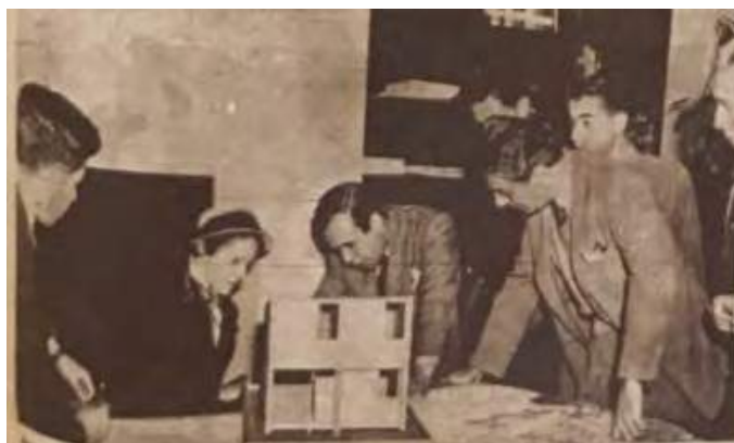
Imagen 21.5. La reconstrucción de Tumaco, Colombia.
