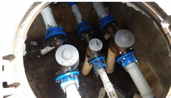
Figura 10. Instalación de medidores para sectores hidráulicos en el barrio La Montana de la ciudad de Manizales (Elaboración propia ,2016)
