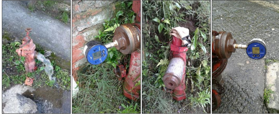
Figura 26. Instalación de los manómetros digitales en la Enea (Elaboración propia con información de Aguas de Manizales, 2017)
