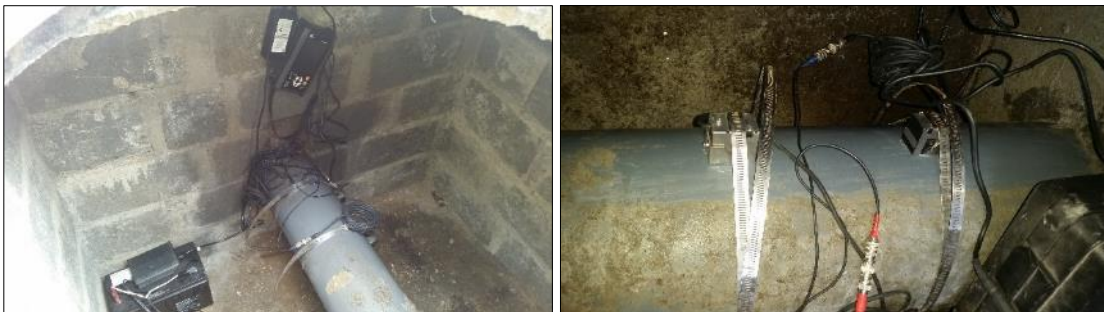
Figura 27. Instalación del medidor de caudal portátil en la Enea (Elaboración propia con información de Aguas de Manizales, 2017)
