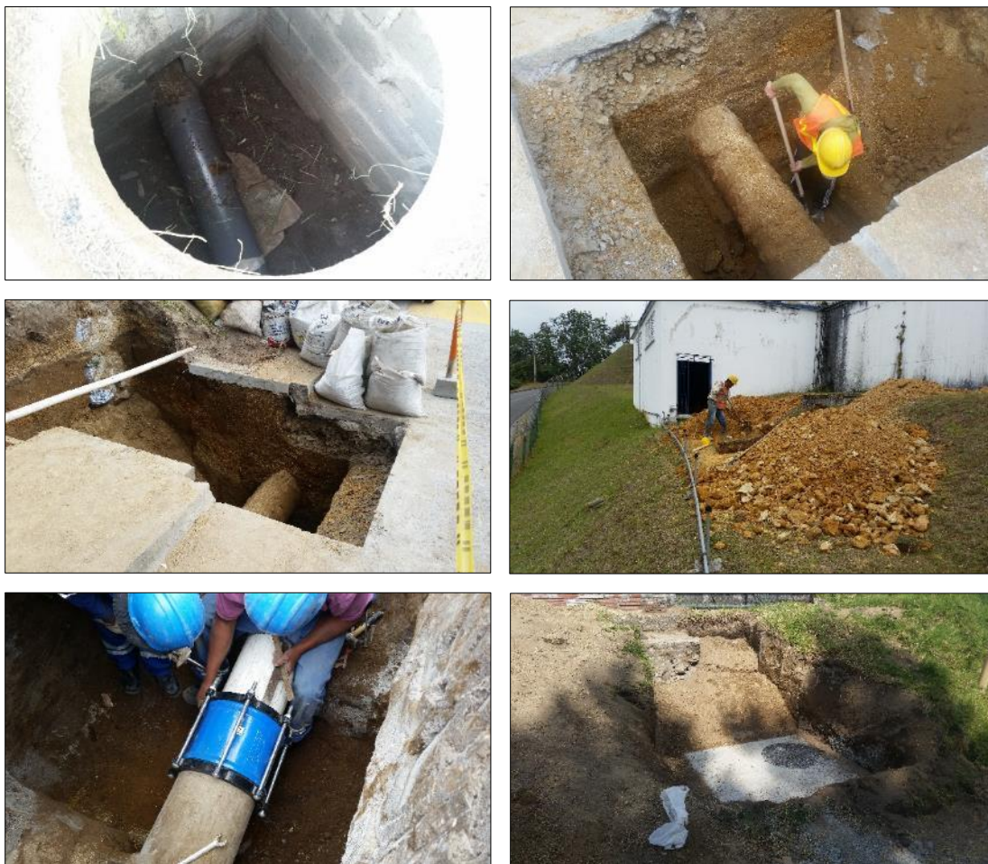
Figura 28. Proceso constructivo de los diferentes puntos de medición (Elaboración propia con información de Aguas de Manizales, 2017)
