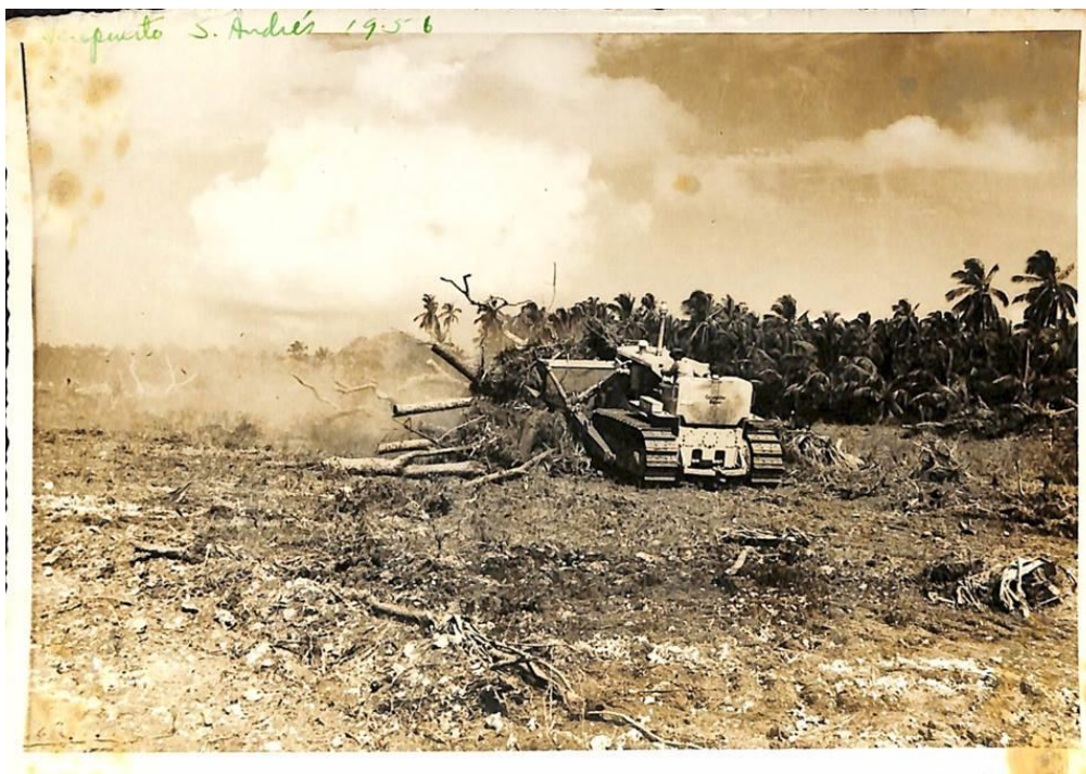
Foto 5. Construcción del aeropuerto entre 1953-1956
