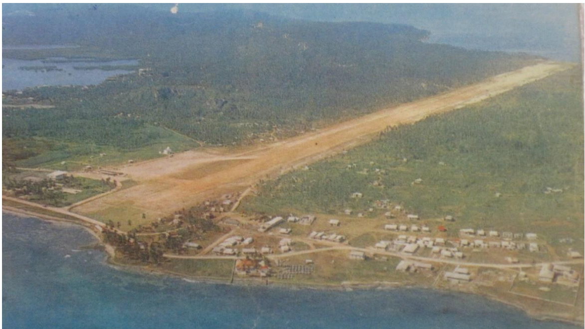
Foto 1. Construcción del aeropuerto Gustavo Rojas Pinilla
