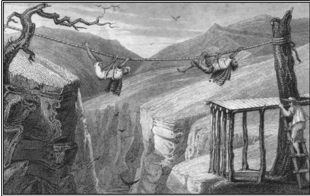
Imagen 2. - Grabado en la crónica de Hamilton, una representación del puente sobre el río Suarez – 1827.
