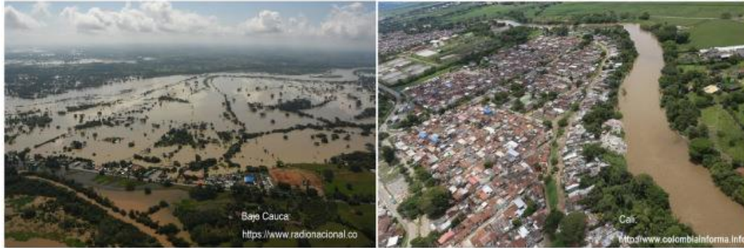
Imagen 06: Nechí en el Bajo Cauca y Jarillón del Río Cauca – Oriente de Cali. Fuente: Radio Nacional y Colombia Informa.
