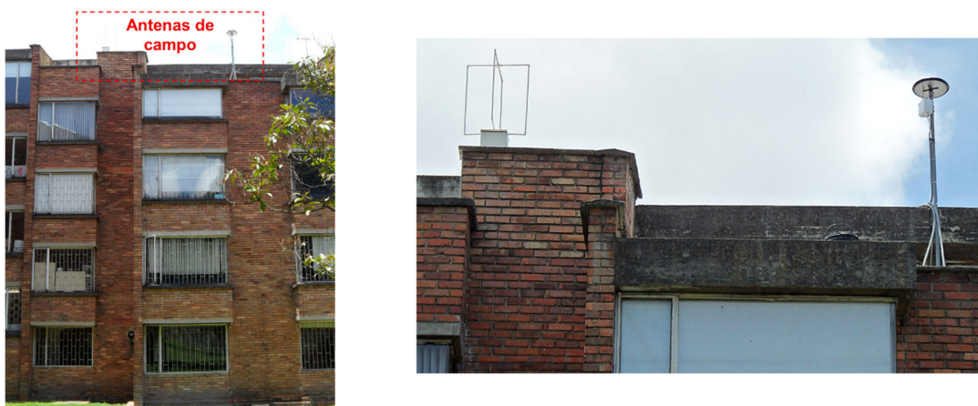
Figura 3.3 Ubicación de las antenas en el techo del edificio Camilo Torres. Izquierda: vista desde el suelo; Derecha: acercamiento a las antenas ubicadas en el techo
