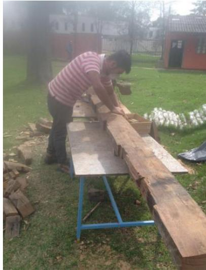
Estas maderas estuvieron expuestas a condiciones medio ambientales (Procesos de Húmedo – Seco – Húmedo, contacto con el pasto, aplicación de peso por tránsito de personal, etc.) durante el retiro de algunas piezas metálicas que no se realizó en la obra de rehabilitación y de la disposición previa al alistamiento en el taller de maderas.
