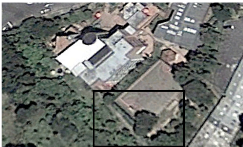
Figura 17. Vista general y detalle de la zona de localización de la malla
