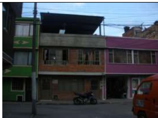
Uso de vivienda consolidado al interior del barrio La Rosita, en su primer piso funcionan algunas tiendas
