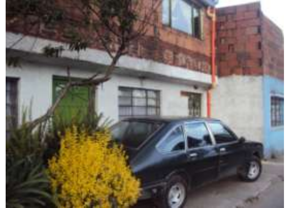
Vivienda de dos pisos en el barrio Puerta de Teja
