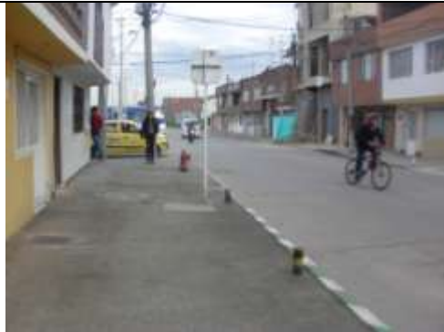
Vista panorámica de viviendas, en el centro una edificación de tres pisos en proceso de construcción con respectiva licencia para uso comercial
