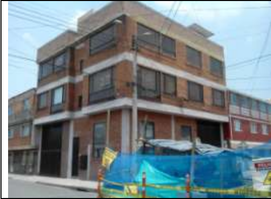
Bodega en inmueble esquinero en vecindad con viviendas de autoconstrucción
