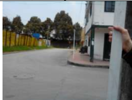
Carrera 106, a mano derecha se observa vivienda en donde Funciona el Hogar de la Tercera Edad El Cariño del Patriarca, cuyo predio se encuentra dentro de área de reserva vial
