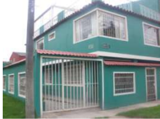
Vivienda con algunos cambios, construcción del tercer piso y modificación de antejardín en garaje
