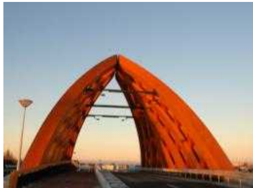
Figura 1-1: Puente Houten Krúsrak - Holanda
