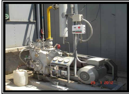
Figura 15: Compresor de Amoniaco para una sistema de Refrigeración
