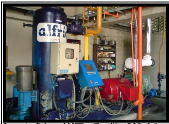
Figura 15: Compresor de Amoniaco para una sistema de Refrigeración
