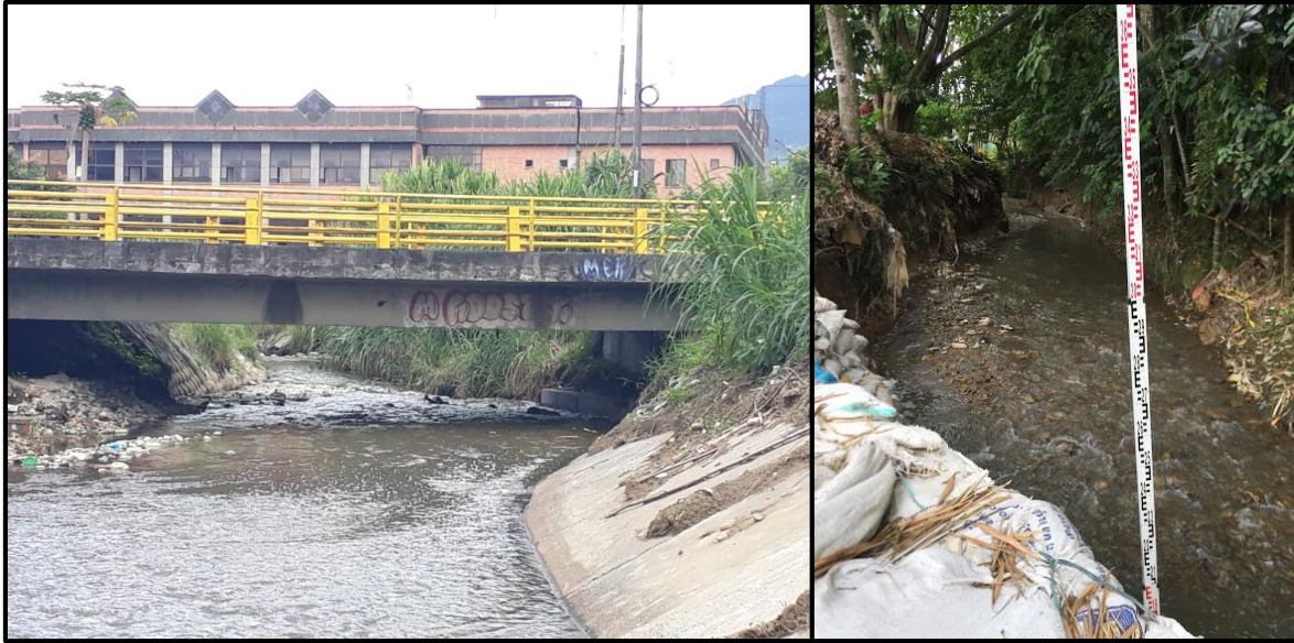
Figura 18: Obras de mitigación y costales de suelo cemento en la quebrada Frailes.
