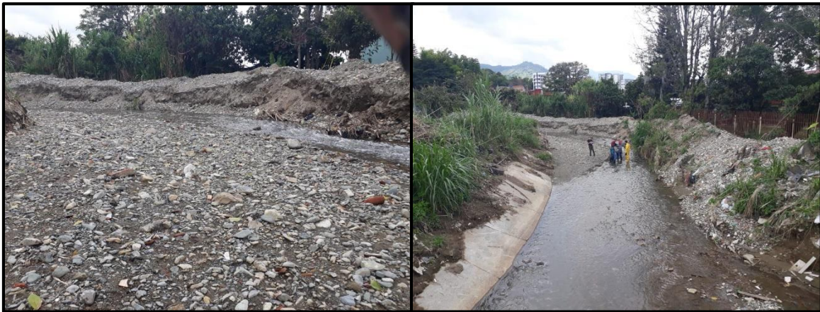
Figura 17: Material del cauce en la zona de aforada 2.
