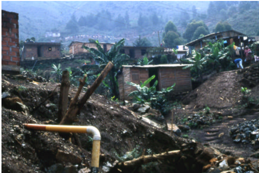
Figura 45. Construcción de viviendas en zonas de alto riesgo por deslizamiento (Sector nororiental).
