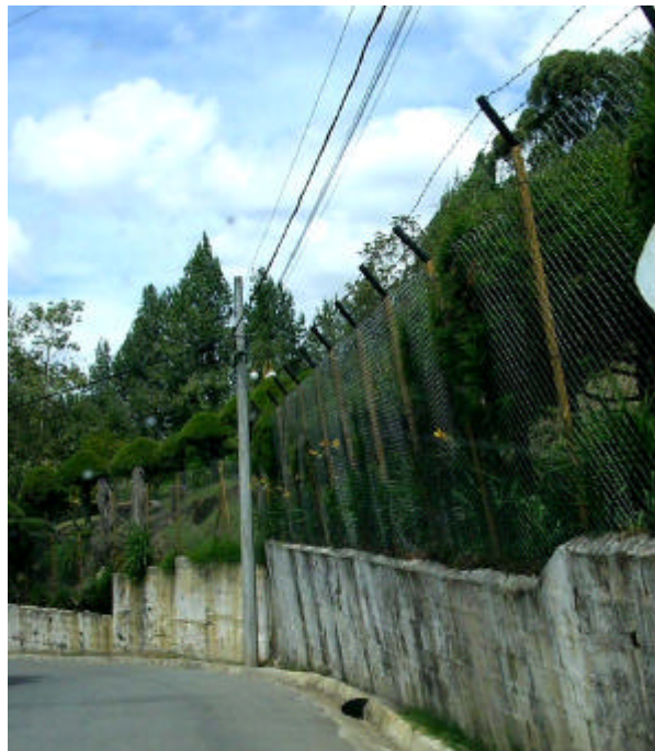
Figura 34. Cierre con muro y reja.
