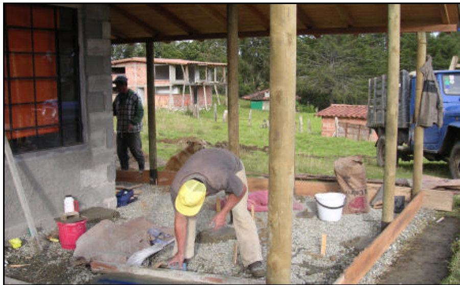
Figura 29. Construcción de viviendas en suelo rústico.
