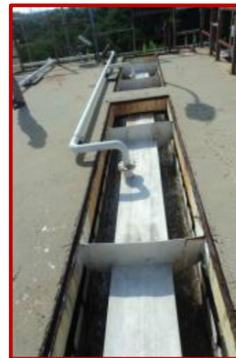
Foto 3-10: Panorámica Reactor 1 y 2. Detalle de recolección de gas en Reactor 1.
