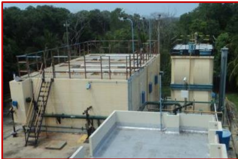
Foto 3-10: Panorámica Reactor 1 y 2. Detalle de recolección de gas en Reactor 1.
