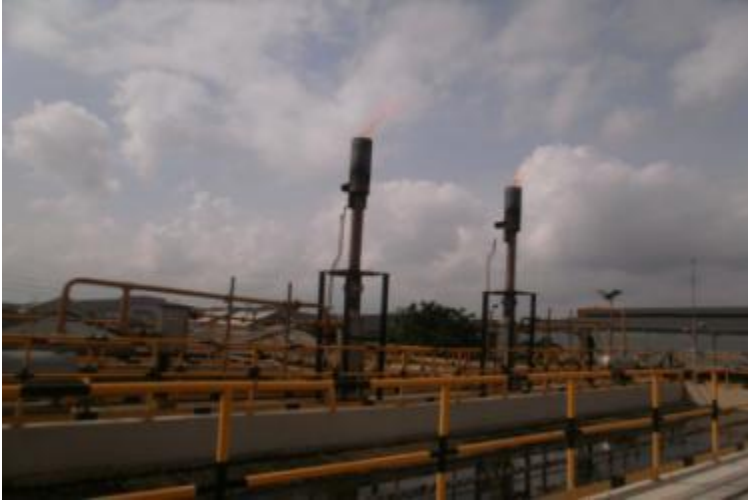
Foto 3-14. Teas quemando el gas metano generado en la operación
