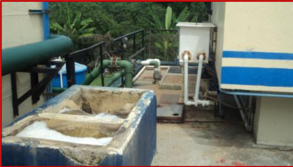
Foto 3-9: Recirculación y tanques de neutralización y bombeo (al fondo).
