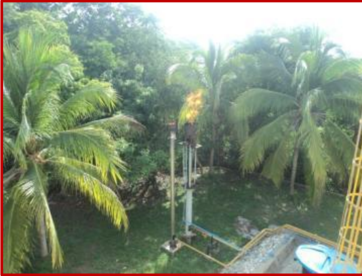
Foto 3-11: Teas quemando gas generado en reactores.
