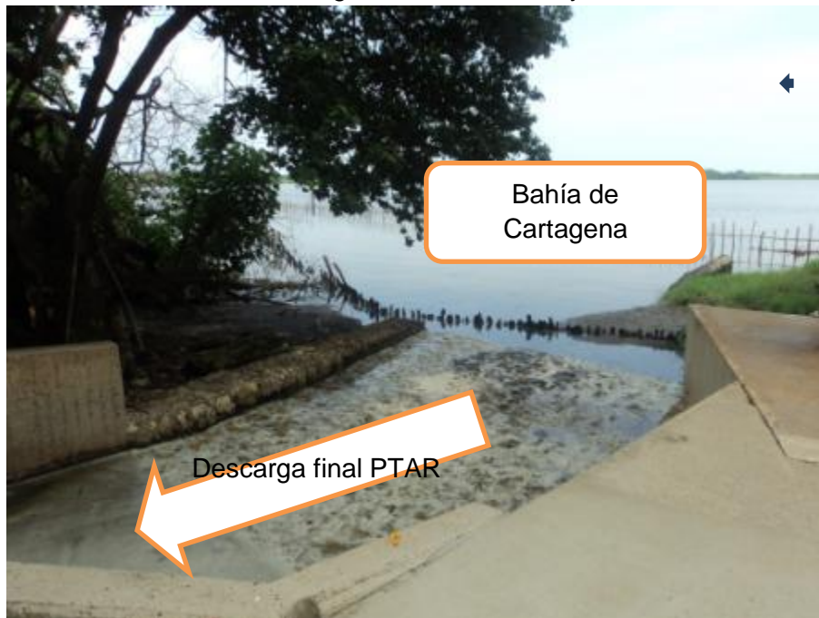
Foto 3-6: Ubicación de descarga final de la PTAR y del sitio de vertimiento
