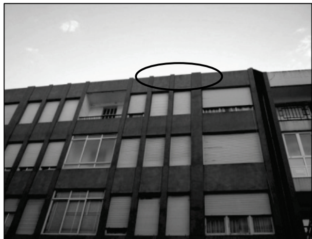
Figura 3. Vivienda C Fuente: Los autores
