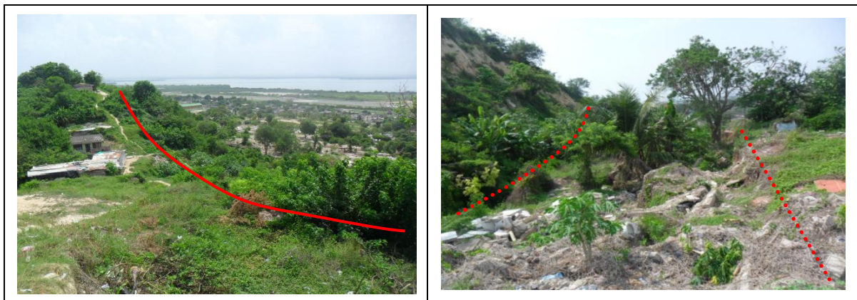
Figura 132. Vista parcial de la corona y zanja de deslizamiento San Francisco
