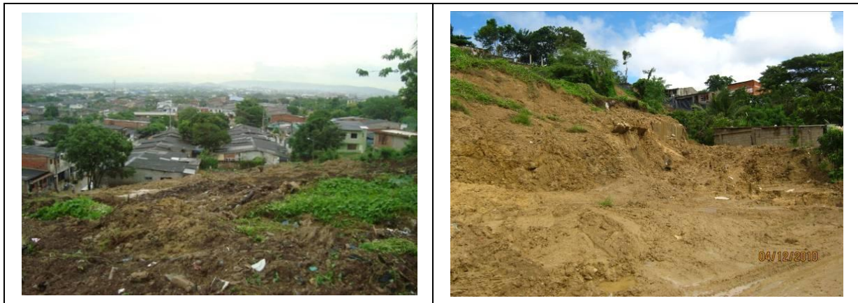
Figura 140. Vista parcial de pie y flanco oriental del deslizamiento de Manzanares
