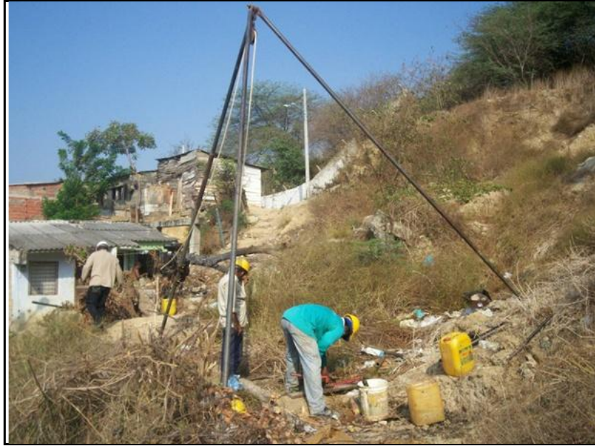
Figura 123. Ejecución de SPT en el sector Lo Amador Fuente: UDC-AMC (2009a)
