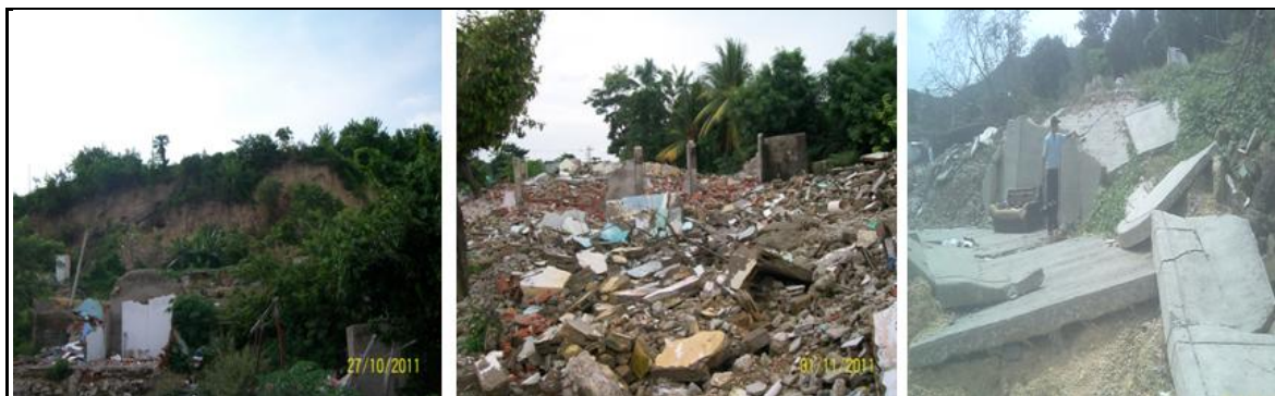
Figura 134. Zonas afectadas por la inestabilidad en el deslizamiento San Francisco
