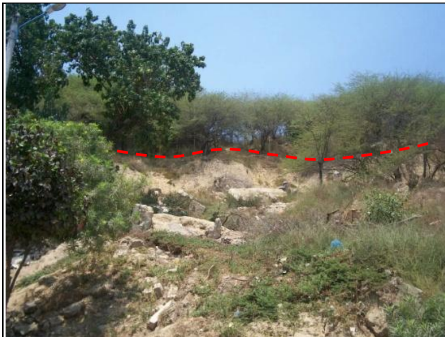
Figura 125. Vista frontal del escarpe principal del deslizamiento Lo Amador
