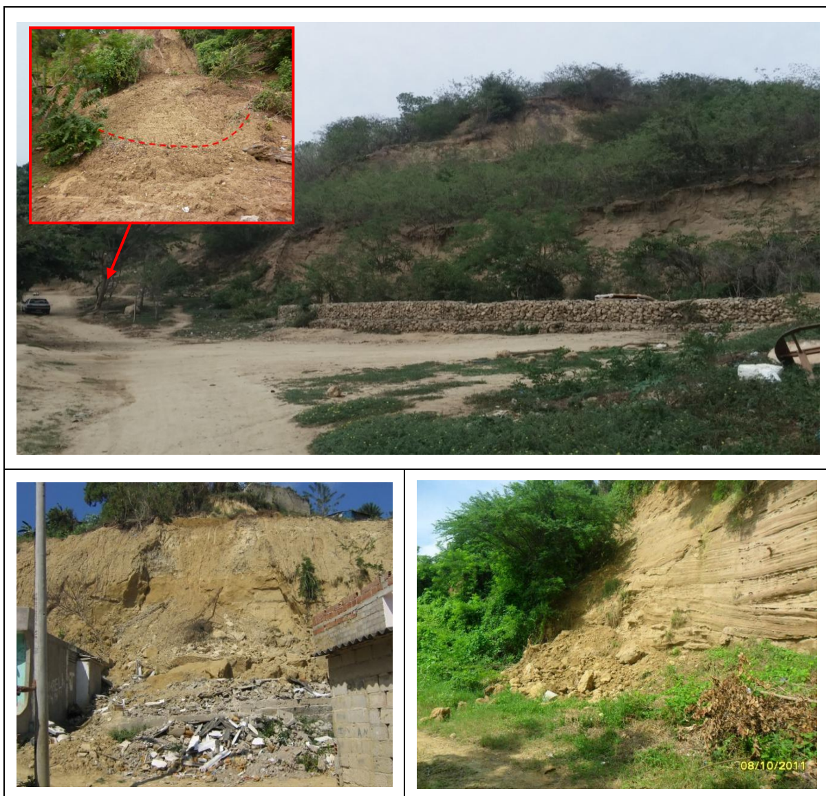
Figura 127. Laderas de la loma del Peyé afectadas por procesos denudacionales
