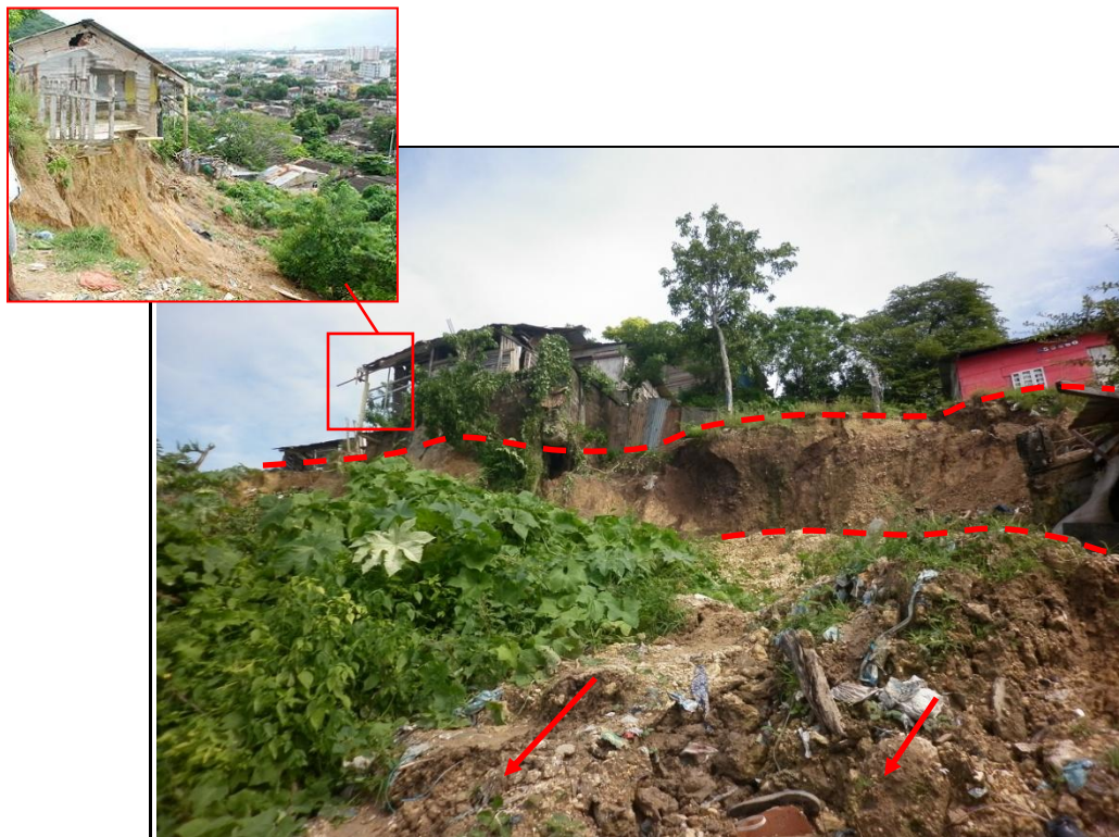
Figura 126. Vista parcial del escarpe principal del deslizamiento: Lomas del Rosario
