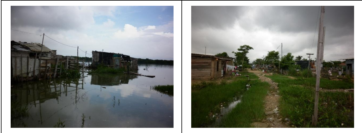
Figura 53. Asentamientos en zonas de rellenos en el Sector El Progreso
