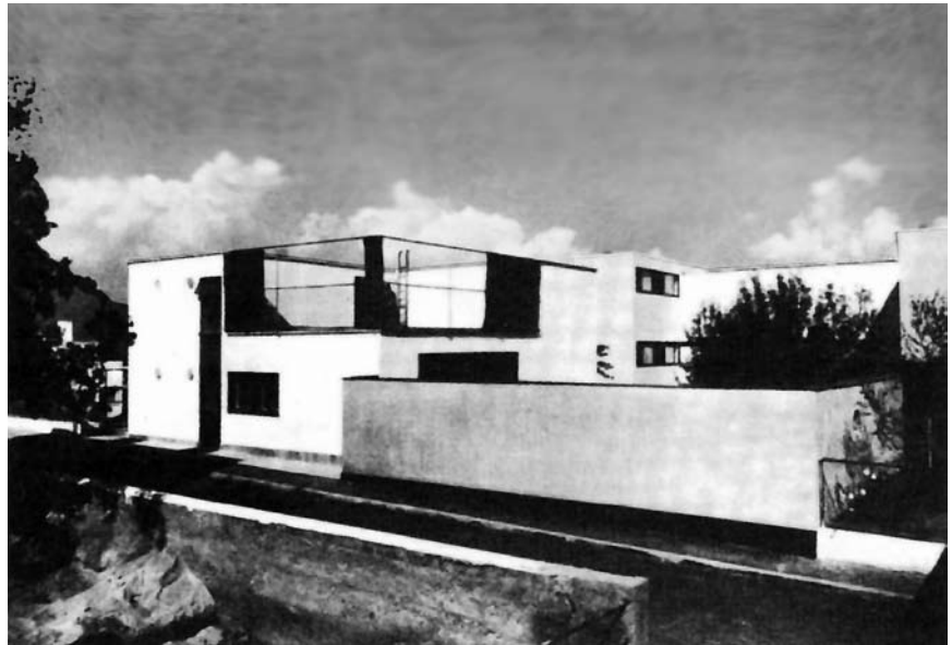
Foto 10 Walter Gropius (1927). Pabellones de la Weissenhofsiedlung. Stuttgart, Alemania.
