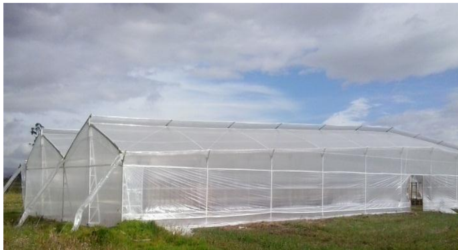
Figura 3-2: Naves de invernadero tradicional con estructura metálica - Ubicación del invernadero en el lote 5
