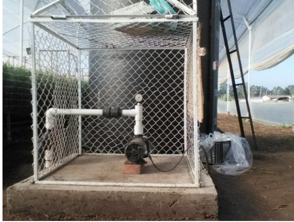
Figura 3-9: Bomba que impulsa el agua desde el reservorio a cada uno de los equipos de bombeo que riegan las camas respectivas.
