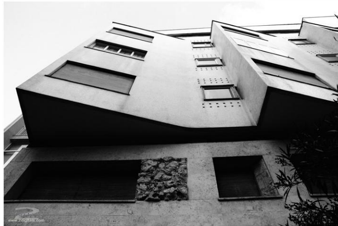
Imagen 65. Detalle de los giros en la fachada del Edificio Il Girasole. Fotografía de Elisa Posella
