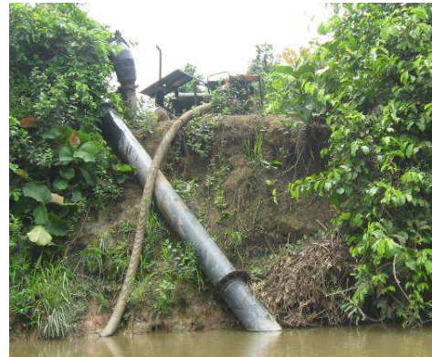
Imagen 18: Tubería para captación de aguas para cultivo. Izquierda: Extracción de agua del Caño Agua de Limón para ser utilizada como agua de riego en cultivo de arroz, aledaño al Caño. Tubería de 4 pulgadas. Derecha: Extracción de agua del Caño Aguas de Limón para ser utilizada como agua de riego en cultivo de arroz. Tubería de 12 pulgadas.
