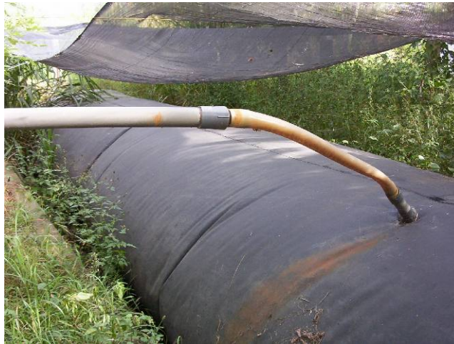
Figura 13. Biodigestor de balón, ubicado en el SENA, Tulúa – Colombia [Foto cortesía de Ricardo Malagón Manrique, Universidad Nacional de Colombia Sede Palmira].
