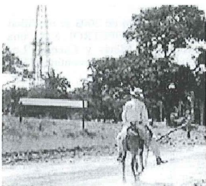
Figura No. 1. Construcción Torre de perforación a principios del siglo XX.
