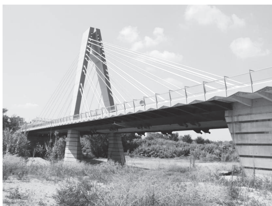
Fotografías 47 y 48 (página siguiente). Puente sobre el río Turia, Valencia. Vista inferior del tablero construido en concreto reciclado; sustitución del 20 % de agregado grueso natural por reciclado. (Fuente: Bedoya, C. 2010).
