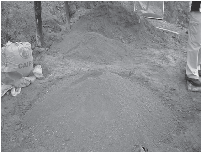
Fotografía 3. Mezclado en el sitio de suelo, arena y cemento. (Fuente: Bedoya, C. 2007).
