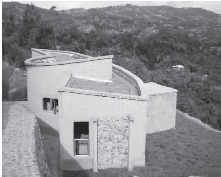
Fotografía 5. Combinación de muros en BSC con pórticos de concreto reforzado.
