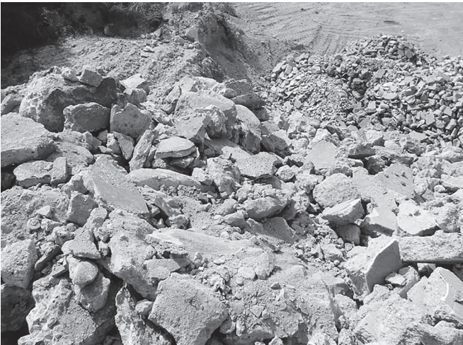
Fotografías 53 y 54. Patio de recibo y descarga de RCD; equipo de trituración de escombros de alto rendimiento. Indural S.A. (Fuente: Bedoya, C.; 2012)
