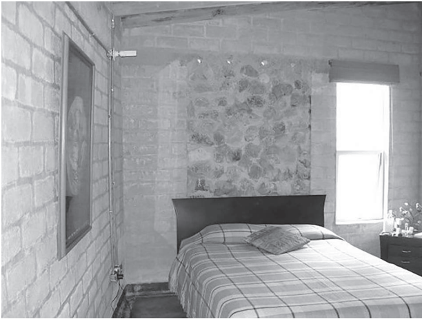
Fotografía 9. Muro en piedra de canto rodado que mejora la temperatura interna de la vivienda. (Fuente: Bedoya, C. 2008).
