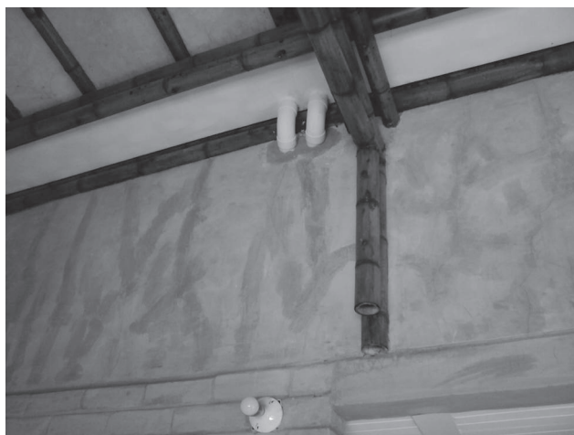
Fotografía 27. Canoa y tubos de recolección de aguas lluvia (Fuente: Bedoya, C. 2014).
