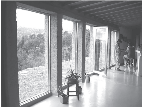
Fotografía 6. Aspecto del piso en concreto pulido y pigmentado.
