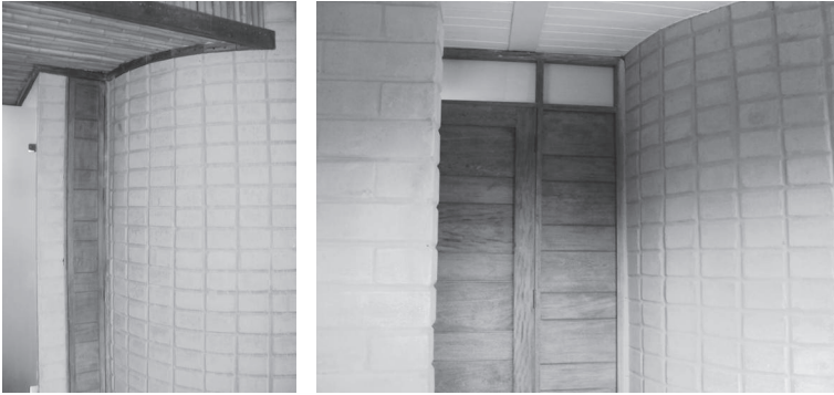
Fotografías 24 y 25. Muros curvos empleando medias piezas producidas con la Cinva-Ram. (Fuente: Bedoya, C. 2014).
