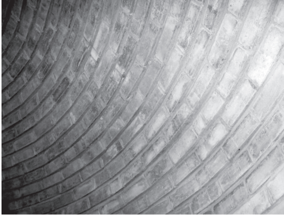
Fotografía 17. Detalle de las hiladas al interior de la bóveda. Gabi Garbeta (Fuente: Bedoya, C. 2010)
