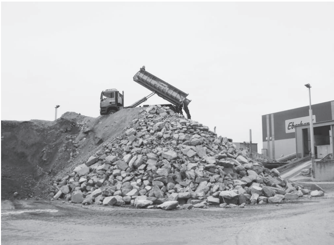
Fotografías 43 y 44 (página siguiente). Vista general de la planta recicladora de RCD Heberhard, en Dübendorf, Suiza; agregados gruesos reciclados para concretos estructurales. (Fuente: Bedoya, C. 2010).
