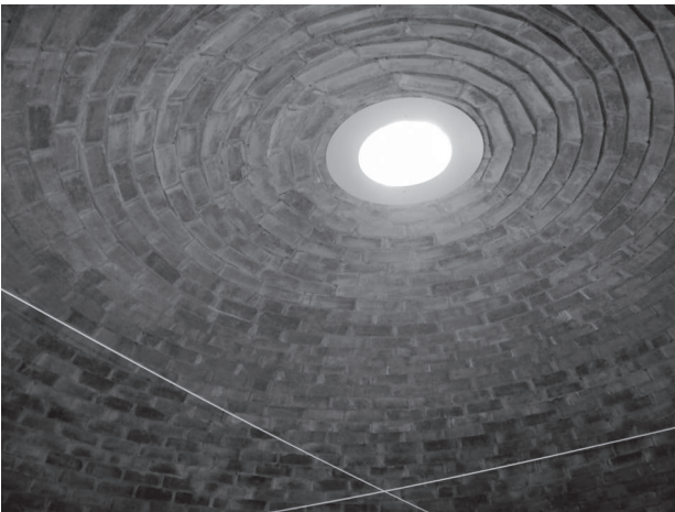
Fotografía 16. Aspecto interior de una bóveda. Gabi Garbeta (Fuente: Bedoya, C. 2010)
