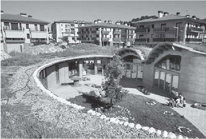
Fotografía 11. Cubierta orgánica y tapias circulares. (Carles Ribas).
