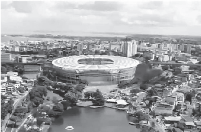
Fotografías 40 y 41. Mejoramiento de vías con agregados reciclados y panorámica del estadio Fonte Nova, en Salvador; Brasil. (Fuente: De Paula, T.; 2011)
