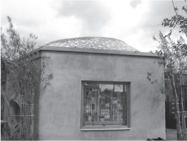
Fotografía 15. Aspecto exterior de una bóveda. Gabi Garbeta (Fuente: Bedoya, C. 2010)
