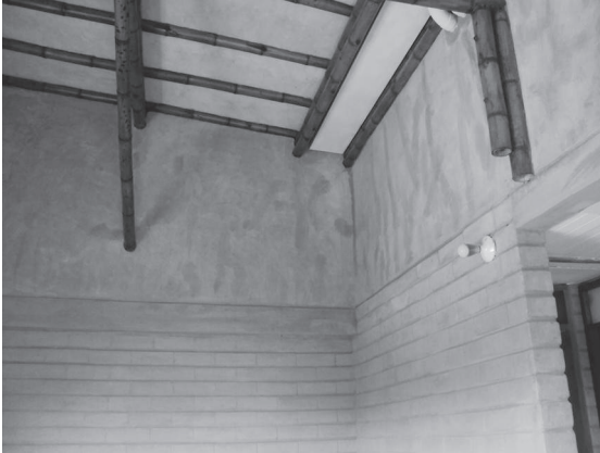
Fotografía 26. Parte inferior en muro porticado y superior en bahareque. (Fuente: Bedoya, C. 2014).
