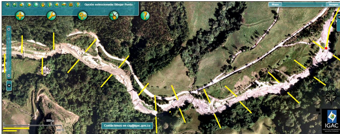
Foto 12. Vista satelital a escala del K 6+376 al K 7+169, tramo de 797,28 m aprox.
