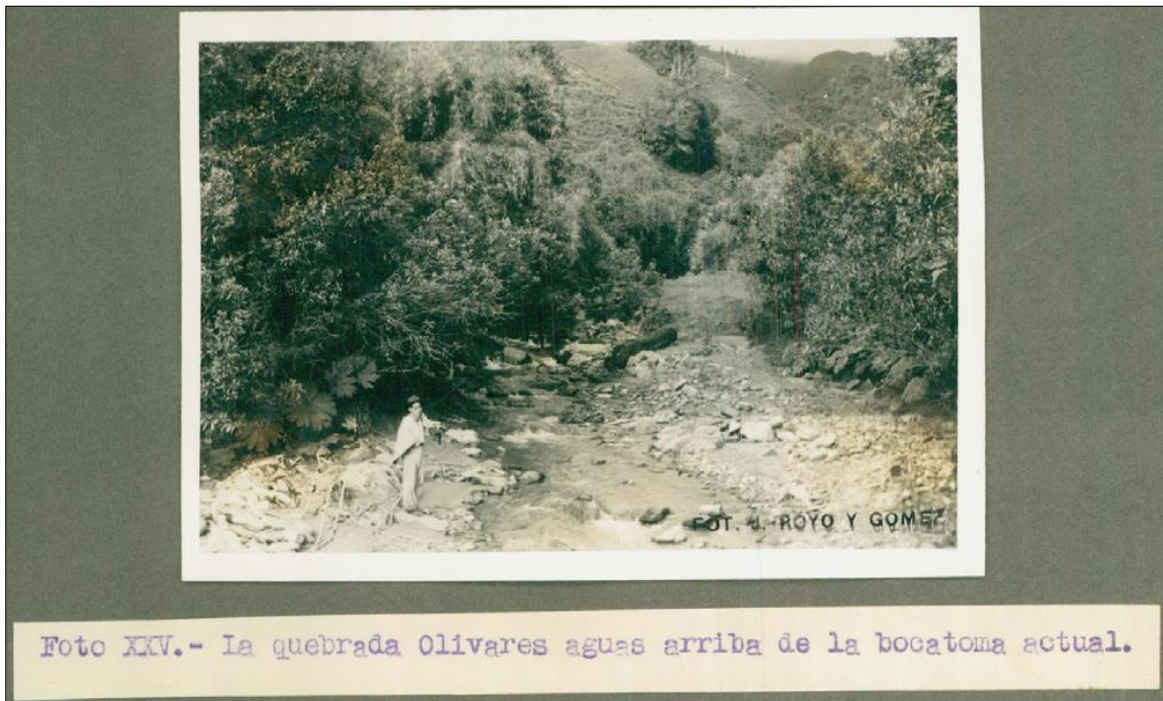
Foto 2. Q. Olivares-Minitas aguas arriba de la Bocatoma en el año 1940
