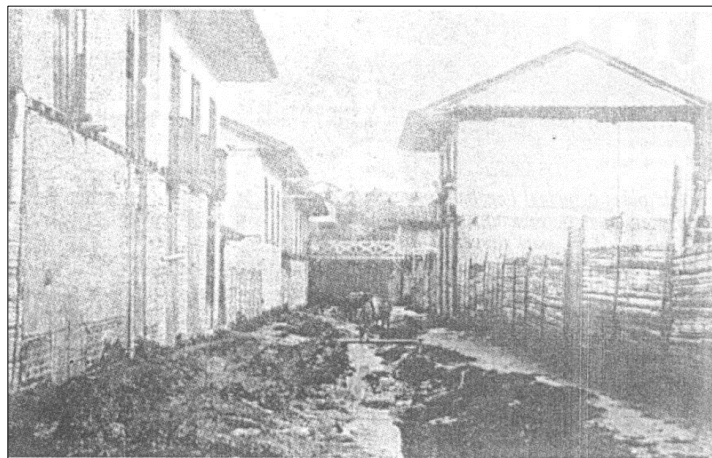
Foto 21. Cañadas que había que rellenar para construir las calles en Manizales
